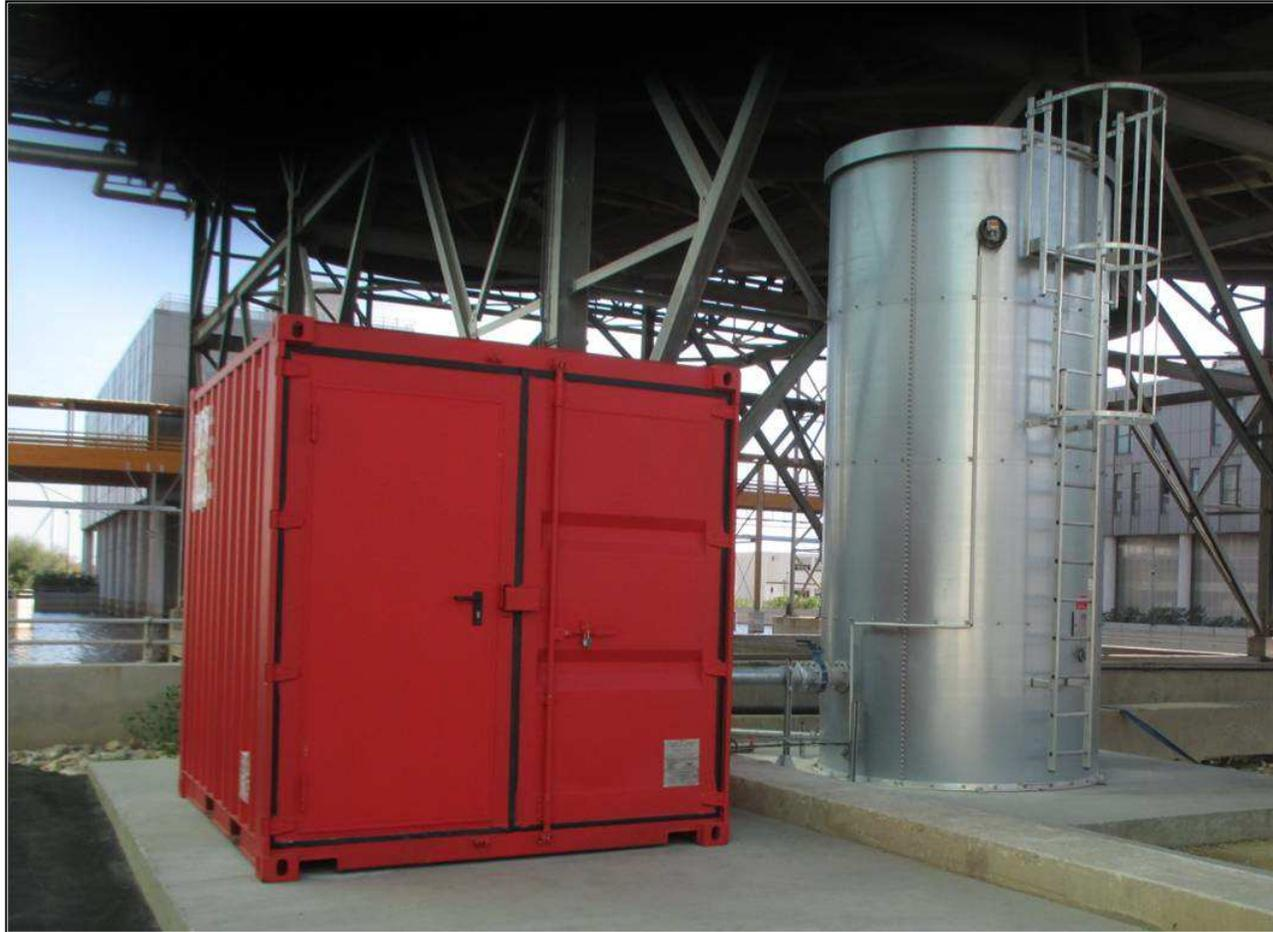
*Création d'une réserve supplémentaire de 18 m<sup>3</sup> d'eau avec surpresseur permettant, en cas de coupure électrique et/ou de coupure d'alimentation en eau, d'alimenter 4 RIA simultanément pendant 20 min en surpression*
