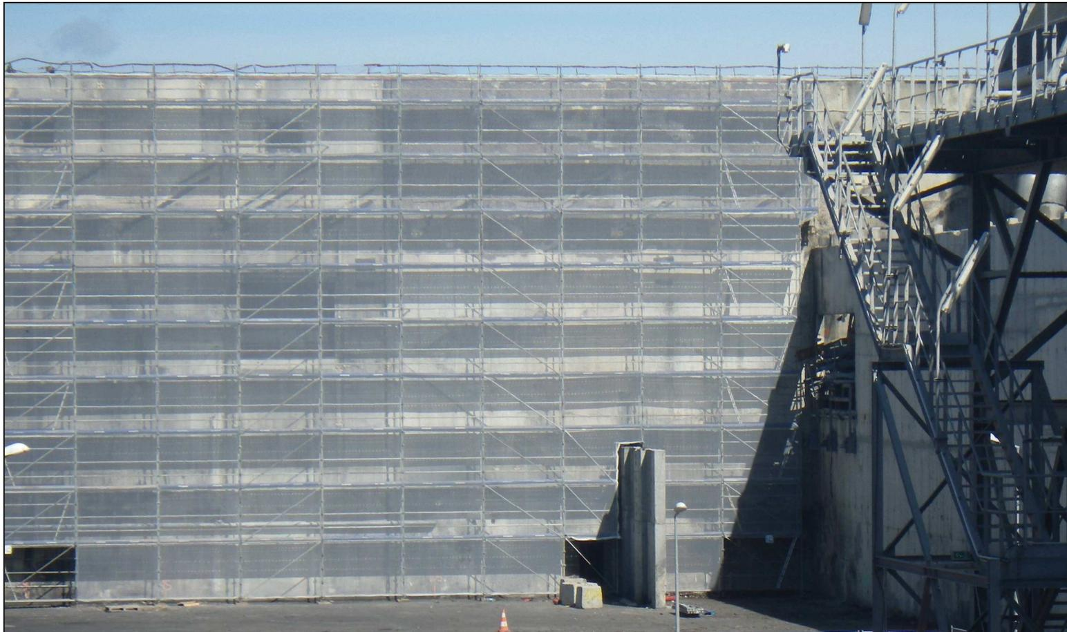
*Echafaudage monté sur tout le mur Nord du bâtiment tri primaire pour la reprise du voile béton*
