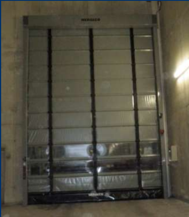
Porte donnant accès à la gare
